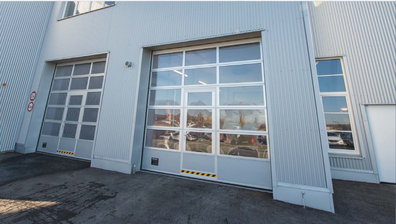
Portes OSF avec panneaux de sol en aluminium blanc RAL 9006 et porte piétonne avec seuil haut
