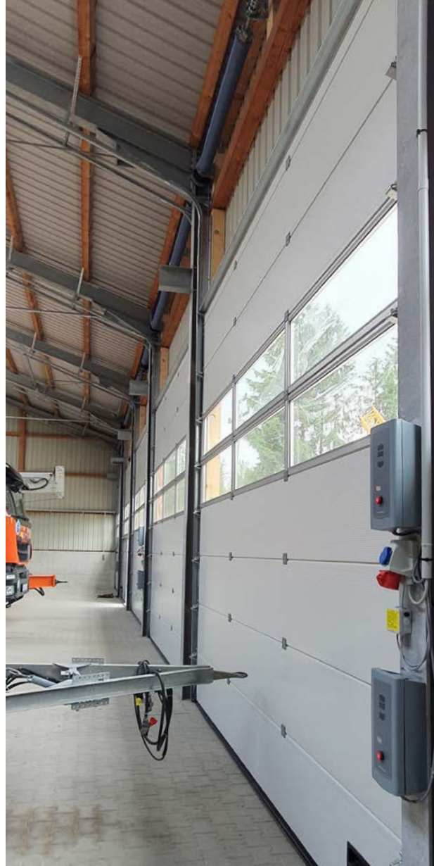
Porte OSP avec élévateur et fixation de l'élément suiveur de toit
